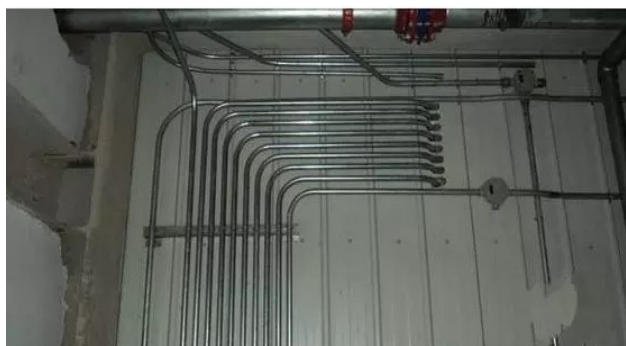
图4 配管安装实景展示图
